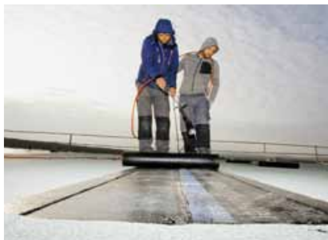
Hochzeit am Hochpunkt: Die letzte Bahn im Firstbereich der Gefälledämmung wird ohne Überdeckungstreifen direkt mit beiden Bahnen, links und rechts, verschweißt.
