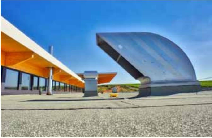
Blick auf die Fläche: Etliche Lüfter für eine wohltemperierte Kühlung im Gebäudeinneren mussten die Dachdecker mit in die Lagen einbinden.
