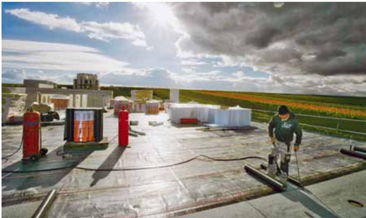
Als erste Abdichtungslage auf der Wärmedämmung verlegten die Dachdecker eine kaltselbstklebende Spezial-Elastomerbitumenbahn mit Duo-Schweißbrand. Die Bahnen wurden von den Dachdeckern nach dem Abziehen der unterseitigen Folie direkt mit der Dämmung verklebt.
